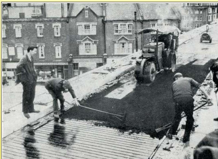
1969 Укладка асфальта на верхнюю проезжую часть развязки Хаммершмидта в Лондоне (Электрический подогрев проезжей части, Роберт Феликс, 1971 г., Музей Ultimheat*)
